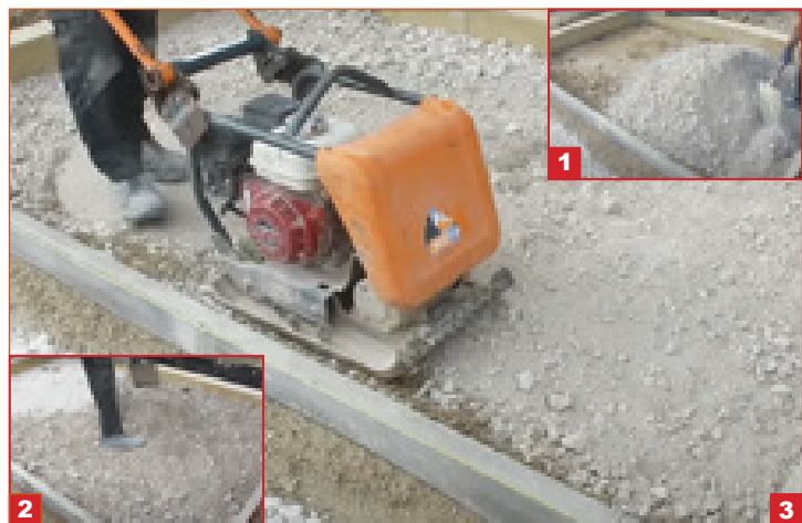
Ugradnja donjeg nosivog sloja (debljina sloja h \geq 15\text{cm} ) 1-Nasipanje; 2-Razastiranje/planiranje; 3-Nabijanje/vibro ploča
