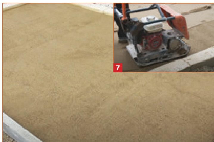
Ugradnja sitnozrnog kamenog materijala do potrebne zbijenosti/ravnosti (7-Nabijanje/vibro ploča)
