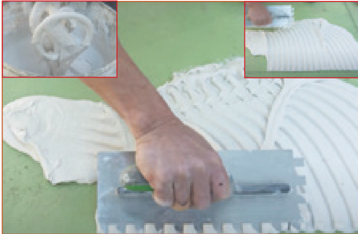
Nanošenje veziva na pripremljenu betonsku podlogu (površinu na koju se ugrađuju/lijepe Premium ploče je potrebno očistiti od prljavštine, prašine i sl..)
