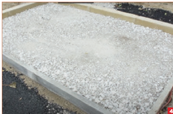
Donji nosivi sloj (ugradnja do potrebne zbijenosti)
