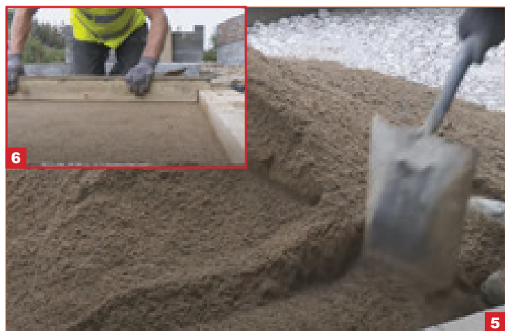
Ugradnja sitnozrnog kamenog agregata (preporuka : od 1 do 3 mm - veličina zrna, debljina sloja: h \geq 4\text{ cm} )
