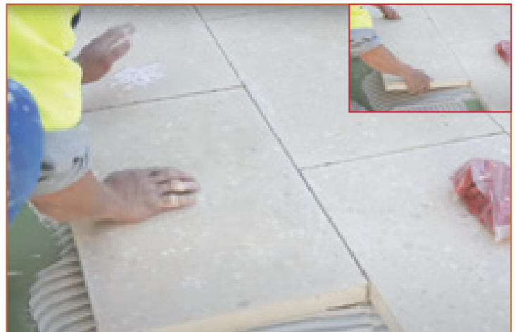
Ugradnja/Polaganje Premium ploča
