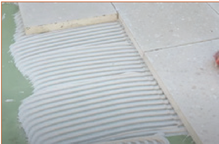
Nanošenje veziva na betonsku podlogu
