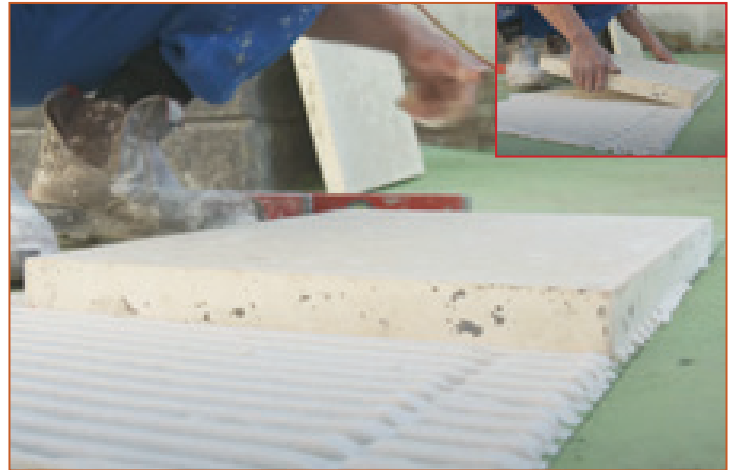
Ugradnja/Polaganje Premium ploča
